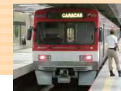
ベネズエラ国鉄向け 列車無線の工事
